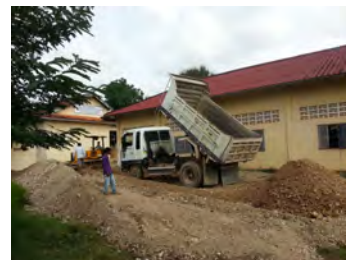
Travaux de terrassement des nouvelles toilettes
