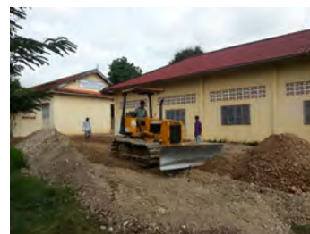
Travaux de terrassement des nouvelles toilettes
